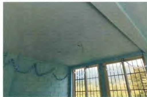
Foto 12: en varias aulas ya no se cuenta con alumbrado por lo que se requiere de colocacion de plafoneras y lamparas LED de rosca
