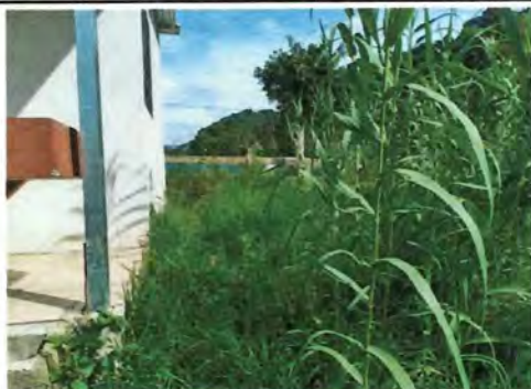
Foto 3: MODULO 1: Colocar base para tinaco e instalación de tinaco de 5 mil litros
