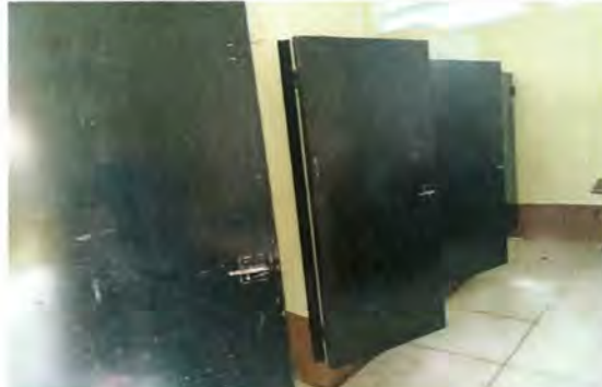
Foto 8: Mantenimiento y reforzamiento de las puertas de los sanitarios
