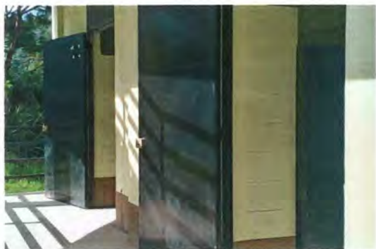
Foto 7: Mantenimiento y reforzamiento de las puertas de las aulas
