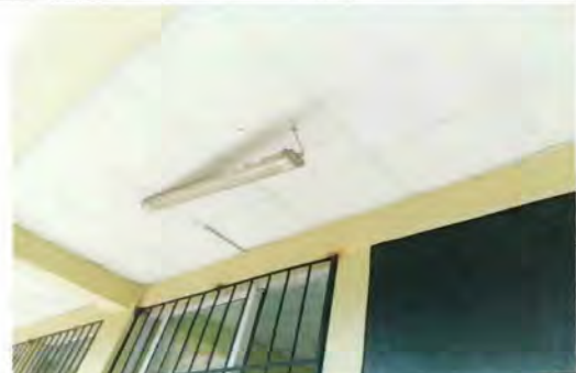
Foto 11: Varias lamparas se han desmontado de su base y ya no prenden por lo que se sugiere sustituirlas
