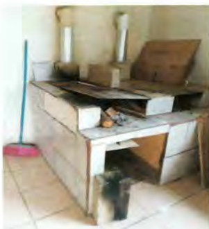
Foto 9: Instalacion de chimenea de ladrillo en virtud que el estado actual no permite la salida de humo
